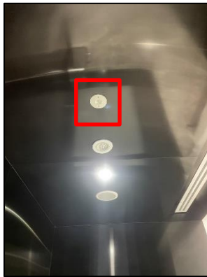
ภาพที่ 76 Movement Sensor ควบคุมการเปิด-ปิดไฟฟ้า
