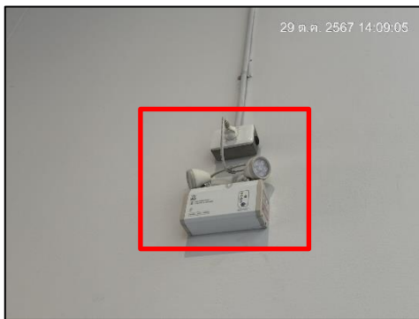
ภาพที่ 31 ระบบไฟฟ้าฉุกเฉิน
