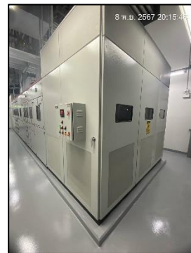
ภาพที่ 32 หม้อแปลงไฟฟ้าชนิด Dry Type
