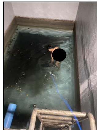
ภาพที่ 10 ทำความสะอาดถังเก็บน้ำ
